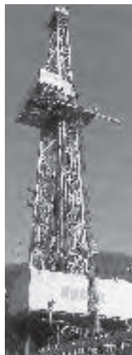
Bohranlage in Bad Urach zur Gewinnung von Erdwärme
