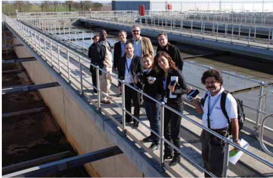
Die Konferenzteilnehmer besichtigen eine Kläranlage der Berliner Wasserbetriebe.
