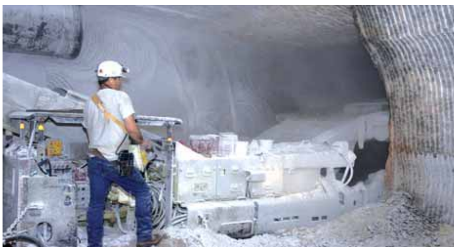
Im US-Endlager Waste Isolation Pilot Plant werden in rund 650 Metern Tiefe Räume in einer Salzformation errichtet.
