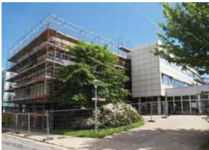
Wird saniert: das Institut für Elektrische Energietechnik.
