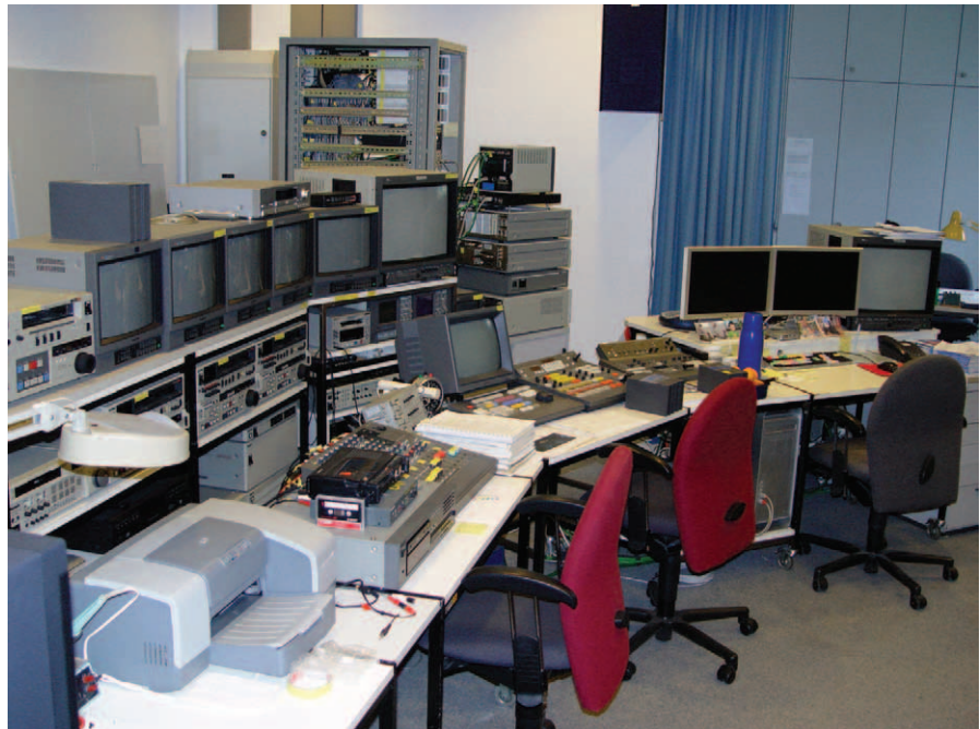
Wurde 1993 im CUTEC-Gebäude installiert: ein Produktionsstudio.
