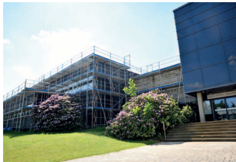
Werkhalle des Instituts für Schweißtechnik.
