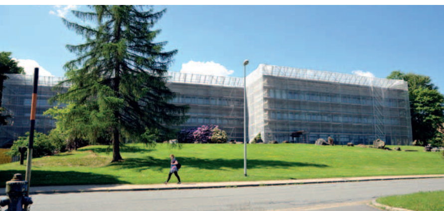
Wird derzeit für 2,5 Millionen Euro saniert: das Geologie-Gebäude.
